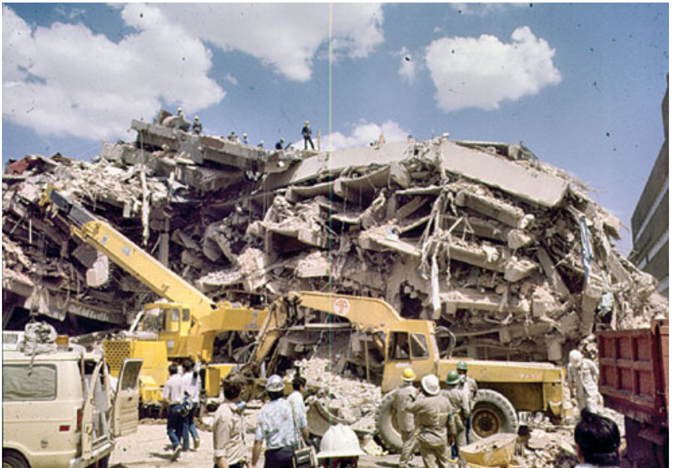
México 1985. Colapso del Hospital Juárez. edificio de 12 plantas (foto A.G.Y.)
