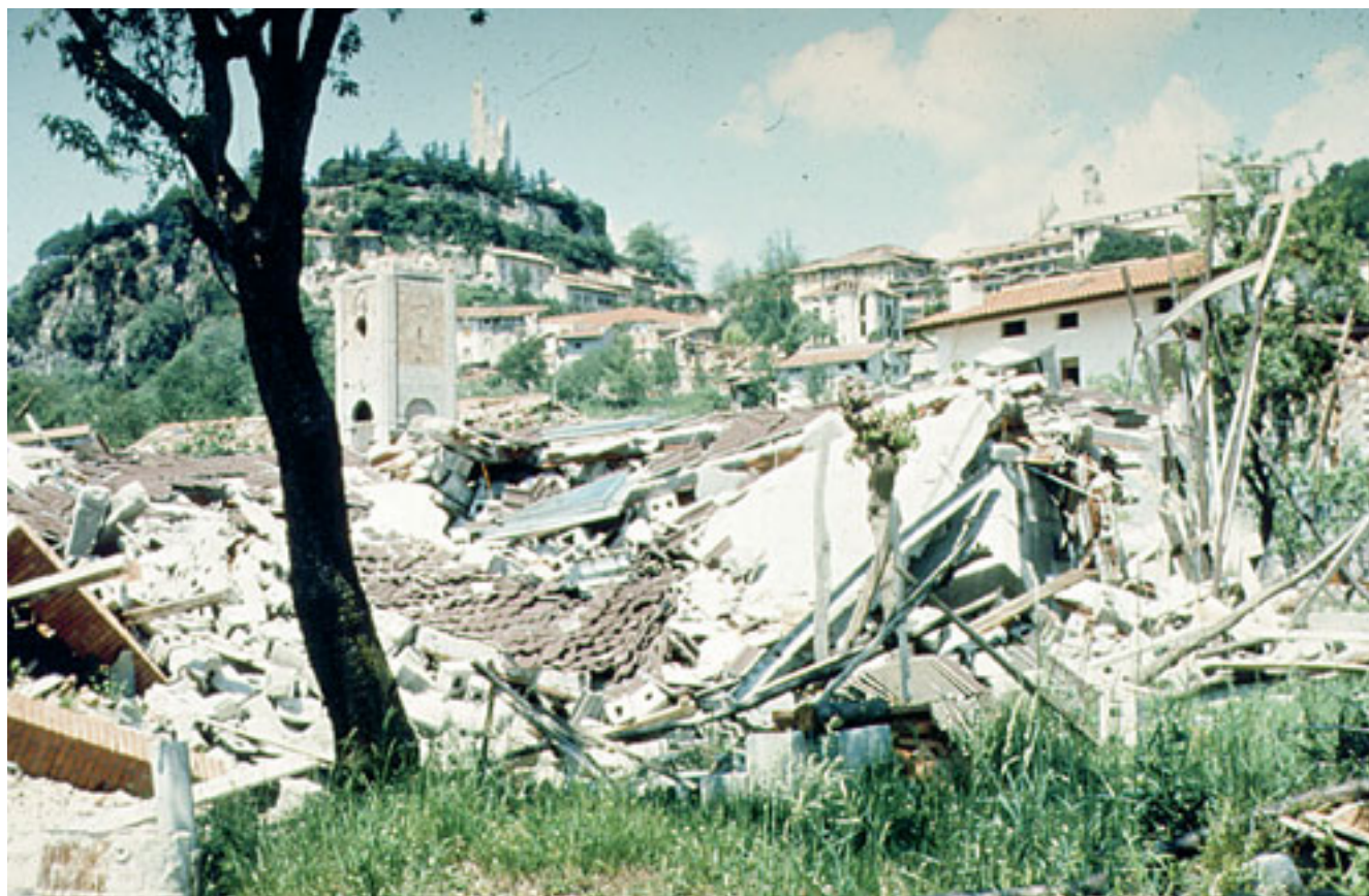
Colapsos generalizados en un barrio de Gemona (foto A.G.Y.)
